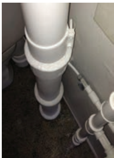
Reparation på faldstamme
