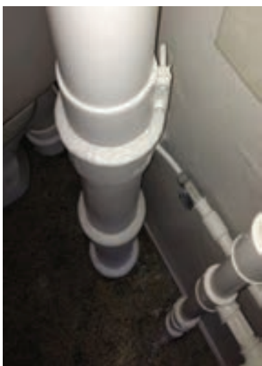
Reparation på faldstamme
