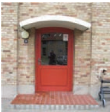
Dør til opgang
